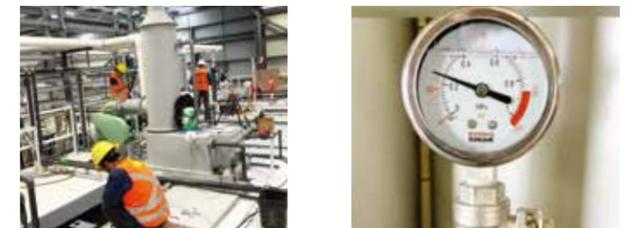
慎重かつ迅速に工事を終えると、試運転検査を開始します。各種の水槽に水を張り、原水槽に近い箇所から順次ポンプを作動。配管の水漏れ、動力の電流値、漏電、回転方向の確認を行います。
